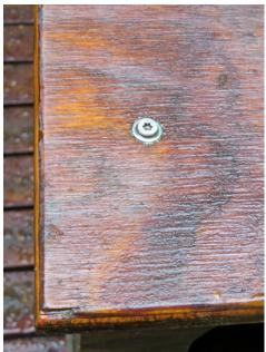
Fig. 3. Sealed Edge Fastener.
